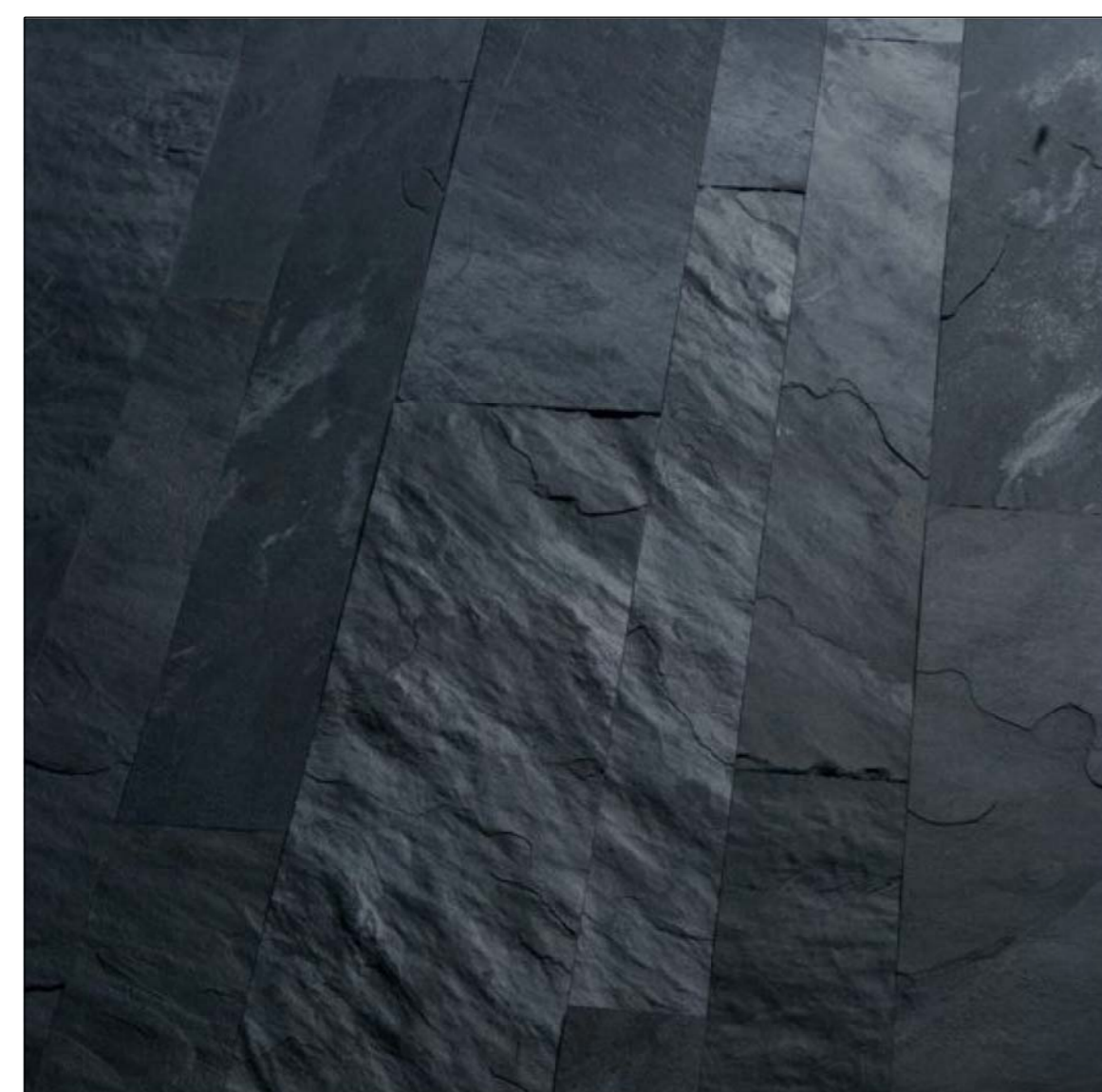
B NÁDRŽ KAŠNY S BRÍDLICOVÝM OBKLADEM - ZVÝRAZNUJÍCÍ BNERUŠENOU VODNÍ PLOCHU
